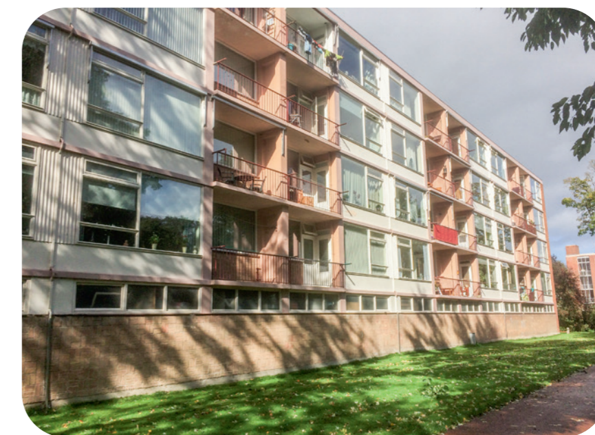
Zo zag het complex Ellen eruit voor de renovatie.
